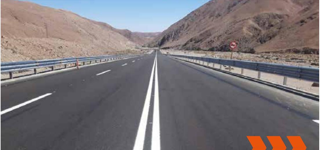
Este tipo de defensas **están certificadas, con pruebas de impacto real**, en laboratorios europeos según la norma EN1317-2, lo cual asegura el cumplimiento del nivel de contención requerido. Cintac tiene dentro de su mix de soluciones los niveles de contención N2, H1, H2, H3, H4b, de acuerdo con norma señalada, en diversos anchos de trabajo.
